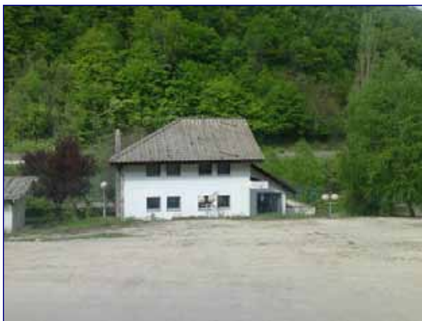
Слика бр. 13 Мотел Изгорка
