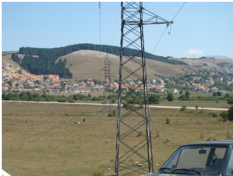
Slika br. 1.1. Postojeći dalekovod 35kV «TE Gacko - GTS I 35/6kV»
